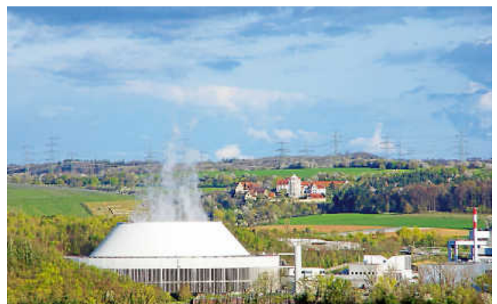
Die Dampfzelle des Gemeinschaftskernkraftwerks Neckarwestheim II war stets von Weitem zu sehen.
