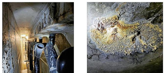
Abb. 2 – Starke Beton- und Bewehrungskorrosion an der Baukonstruktion
