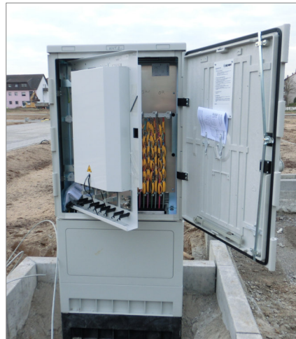
Netzverteiler
