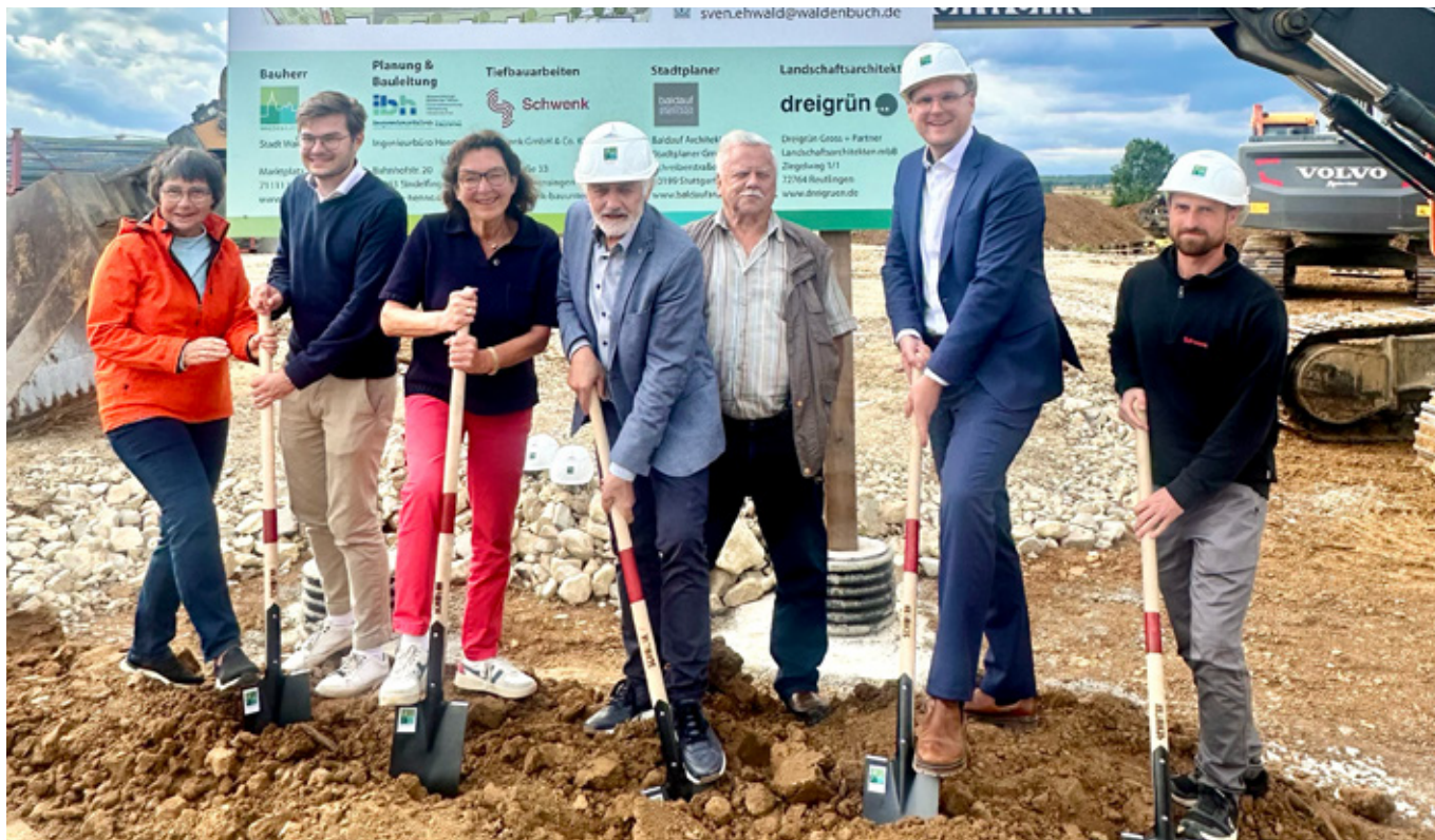
▲ Heidrun Rohse, Leon Kolb, Annette Odendahl, Egbert Henne (Ingenieurbüro Henne), Walter Keck, Bürgermeister Chris Nathan und Richard Scherer (Schwenk GmbH & Co. KG) beim symbolischen Spatenstich
