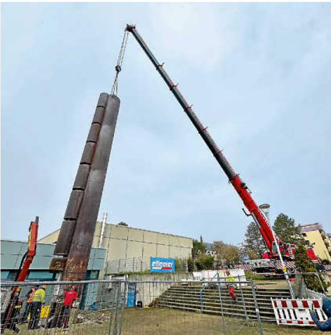
Demontage des alten Cortenstahlkamins und direkt daneben der neue Edelstahlkamin.
