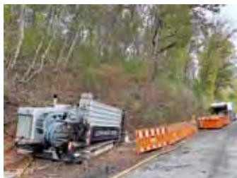
Um an der alten Dettenhäuser Straße keine zusätzlichen Straßenbauarbeiten durchzuführen, entschied man sich dazu, die Leitung bergauf zum Turm an der Weilerbergstraße mittels Spülbohrung durchzuführen. Aufgrund der Länge der Strecke (ca. 120 m) und Baumbewuchs, sowie Felsanteil im Boden keine ganz einfache Maßnahme.
