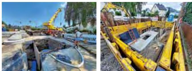
Nach intensiver Vorbereitung haben im August die Arbeiten zur Sanierung des Lerchenwegs begonnen. Bis zum Frühjahr wird dort an der Erneuerung der Wasserleitung sowie der Erneuerung und größerer Dimensionierung der Kanäle gearbeitet. Die komplette Asphaltfläche wird erneuert. Ebenso wird nach Abschluss der Arbeiten eine moderne LED-Beleuchtung installiert sein. Im Zuge der Maßnahme hat die Telekom ein aufwändiges Betonbauwerk im Querungspunkt Echterdinger Straße erneuert.
