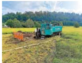
Bei der Verlegung der Leitungen kam ein sogenanntes Bohrspülverfahren zum Einsatz. Dies ermöglichte eine Verlegung der Leitungen ohne aufwändige Grabarbeiten.
