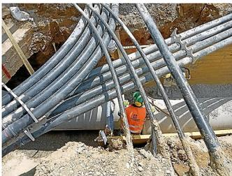
Abb. 3 - Aushub unter Medienleitungen „von Hand“
