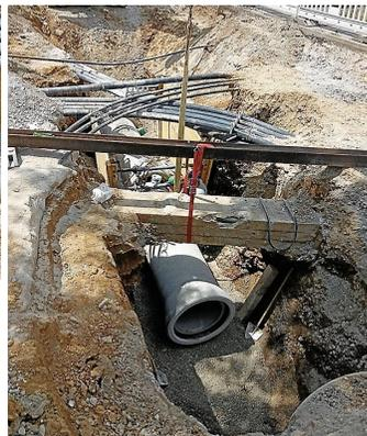
Abb. 4 - Einbringen von Kanalrohren unter Bestandsleitungen
