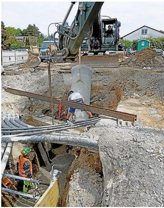
Abb. 2 – Einbringen der Kanalrohre „von Hand“
